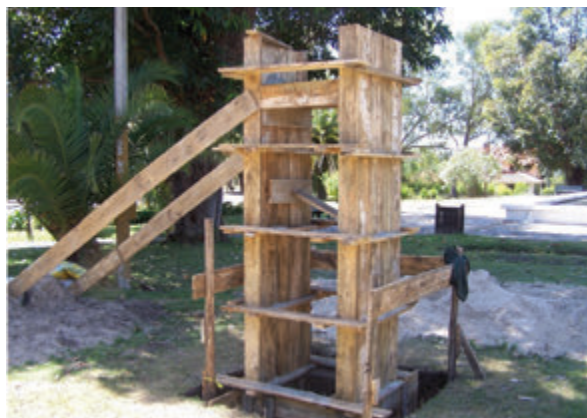
Encofrado, relleno con hormigón - Setiembre 2011
