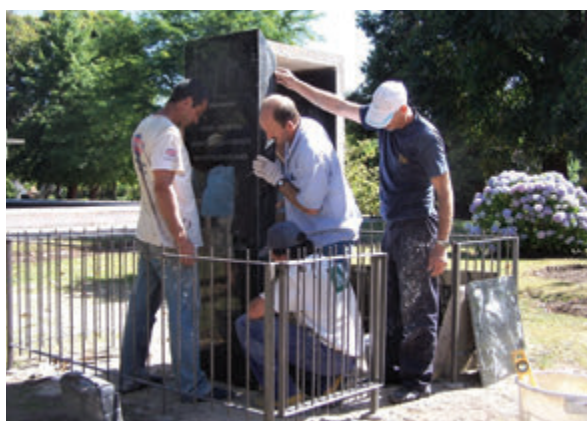
Obreros de “Abbate” colocando las placas de granito
