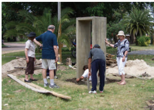
Finalizando parte del hormigón - Obreros con O. Píriz, N. Recoba, P. Báez (oculto), A. González
