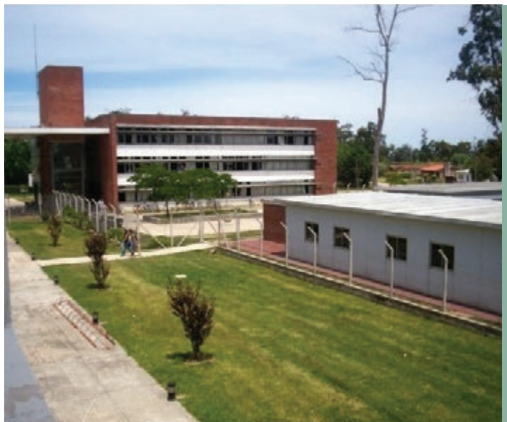
📷 Edificio del Liceo N° 2. A la izquierda de la imagen está el CERP del SUR
