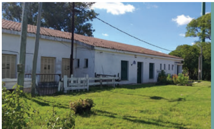
Frente de la Estación de Ferrocarril (reciclada) - Foto A.G.B. 2022
