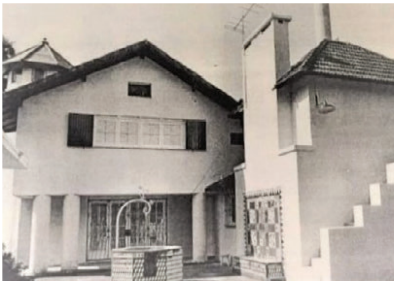
Fondo original - Aberturas, aljibe y banco pared.
