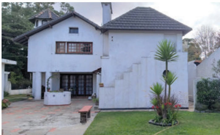
Fondo actual - Se ve el pórtico trasero - Aberturas, aljibe reformados. A.G.B. 2022.
