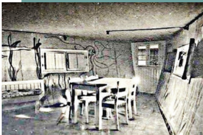
Interior de parte derrumbada - Foto Tribuna Interbalnearia.
