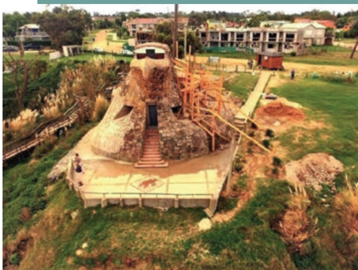
📷 Trabajando en refacción 2018 - Foto Alfredo Pereira
