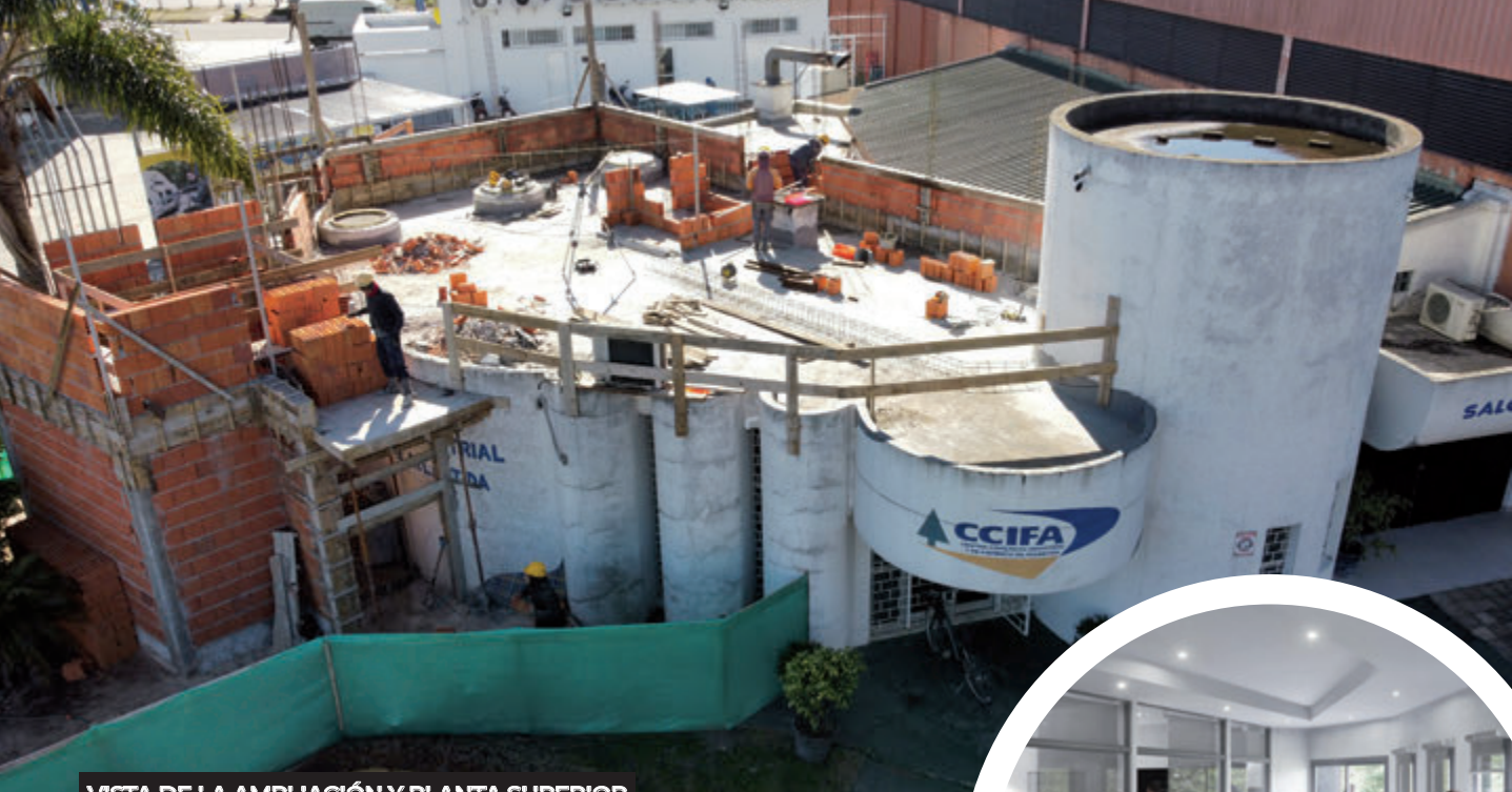
VISTA DE LA AMPLIACIÓN Y PLANTA SUPERIOR
