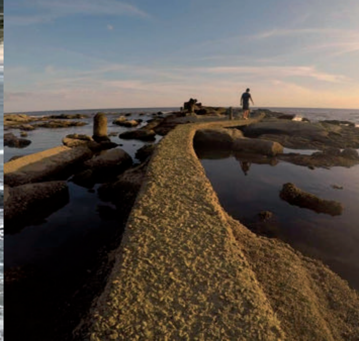
📷 Vista de una de las plataformas.
