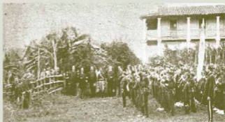
● Lugar donde habría estado la casa de Artigas (a la izq.).
