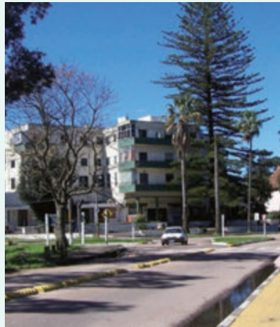
Edificio Atlántida actual.
