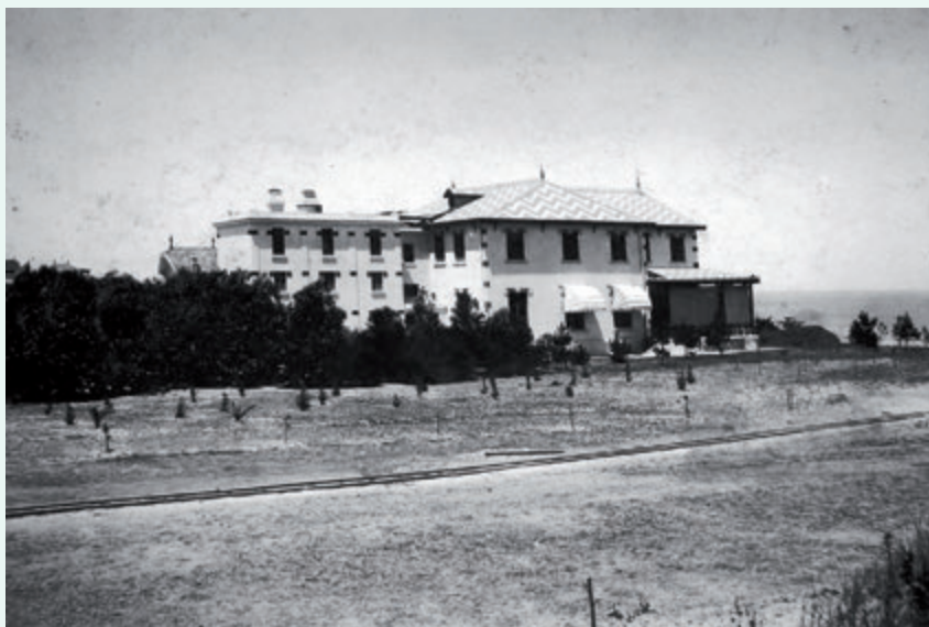
📷 El Edificio ya con reformas.
