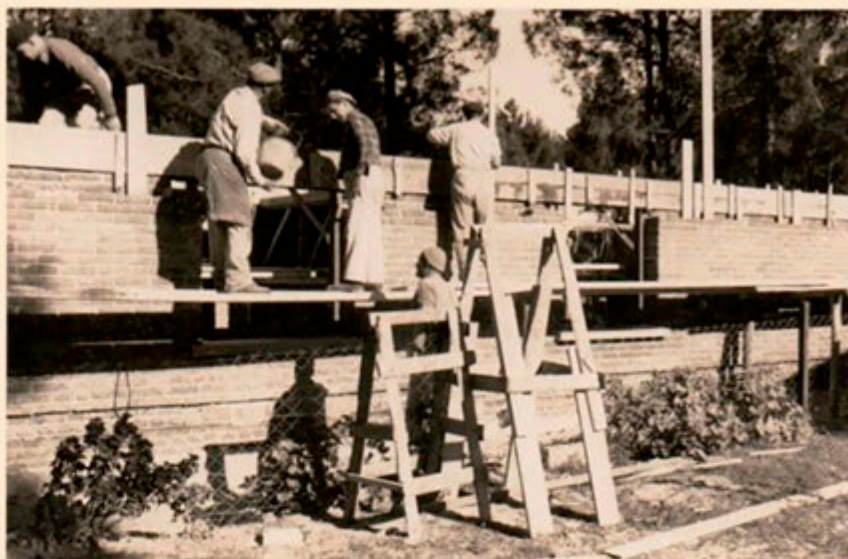
📷 Construyendo el Cine Atlántida
