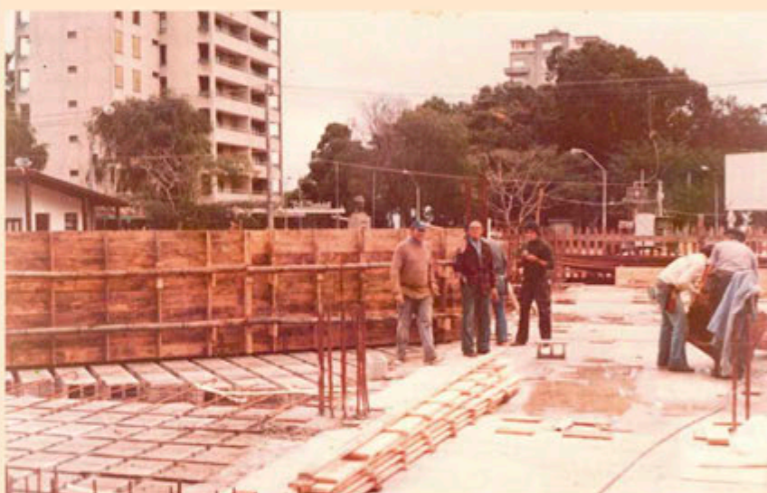
📷 Construyendo el Portofino.
