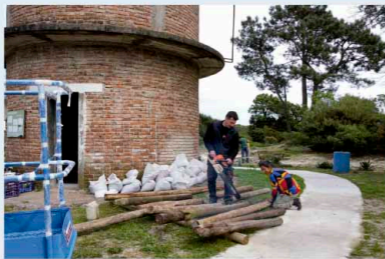
Vecinos cortando postes para cerco perimetral.
